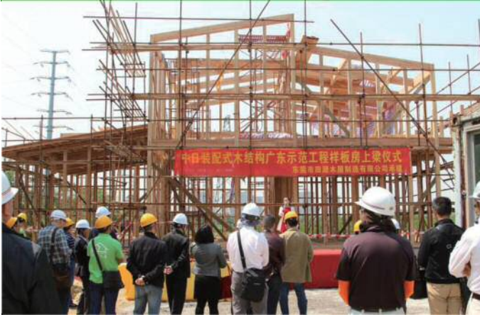
広東省東莞市に整備した軸組工法のモデル住宅の構造外観
