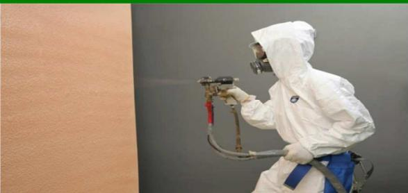
アキレスは6月1日、2013年11月から北海道で限定販売していた吹付け硬質ウレタンフォーム「アキレスエアロンFR-FO」を全国で発売する。オゾン破壊係数は0だが地球温暖化係数が高い「代替フロン」タイプと、地球温暖化係数は低い断熱性能に劣る「ノンフロン」タイプのデメリットを解消。地球温暖化係数の低い新しい発泡剤「HFO」を使用することで、高い断熱性能と環境負荷軽減の両立を実現した。従来のノンフロンタイプよりも断熱フォームの厚みを薄くすることができる。熱伝導率は0.026W/m・k以下。
