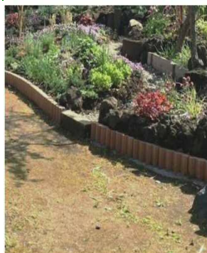
施工例：施工前(左)
