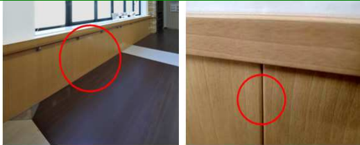
<「セラル R エッジ」の施工例(腰壁)>
